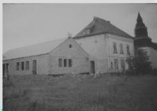
Bild13 DGH im Rohbau Fotograf unbekannt
