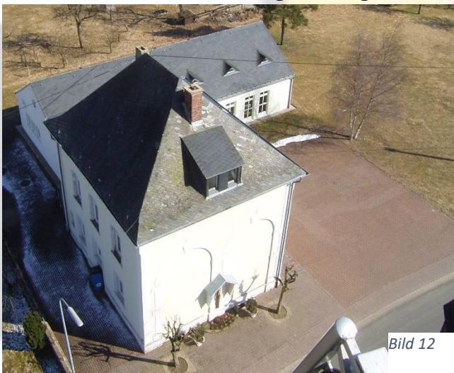
Das DGH nach der Fertigstellung
