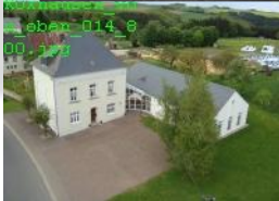
Bild12 DGH nach der Fertigstellung Fotograf Helmut Jakoby
