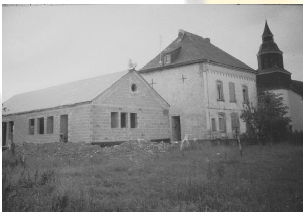
DGH im Rohbau 1993
